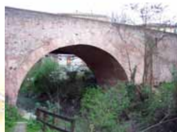
15. Ponte di Corticella: ricostruito dal Vignola nel 1548; a fianco rimane l'ex Dogana del porto di Corticella, un tempo utilizzato in alternativa al porto cittadino. Sulla riva destra del canale era attivo il Parco delle Ponti (1826), luogo dove sgorgavano acque minerali. Linea bus 27.
