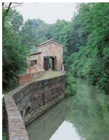
3. 3a. Paraporto Scaletta detto Casa dei ghiacci: è posto all'inizio di un tratto del canale pensile regolato da altri due paraporti (detti Verocchio e San Luca). Le strutture, restaurate nel 2009, sono visibili da via Scaletta e al termine di via Canale, o dall'alto percorrendo la ciclabile Bologna-Casalecchio; linee bus 89, 20, ferm. Municipio.
