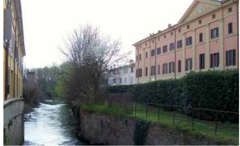
17. Sostegno di Castagnolo: costruito a fianco del Mulino dei Gozzadini, già attivo nel 1516. Gli edifici del borgo, detto Mulini Nuovi, furono ricostruiti nell'800 dall'architetto Angelo Venturini per i marchesi Pizzardi. Si raggiunge in auto da via Saliceto-via Matteotti a Castel Maggiore.
