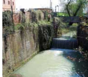
12. Sostegno Landi: eretto a fine '500 in forma esagonale, è affiancato da edifici sorti in luogo dell'antica cartiera, della quale resta traccia nel muro confinante la conca; tra i due canali restano due case riferibili alla custodia del sostegno. Si raggiunge da via dell'Arcoveglio-via della Cooperazione-via del Sostegno; linee bus 11, ferm. Cooperazione. In bicicletta seguire il sentiero fra i due canali.
