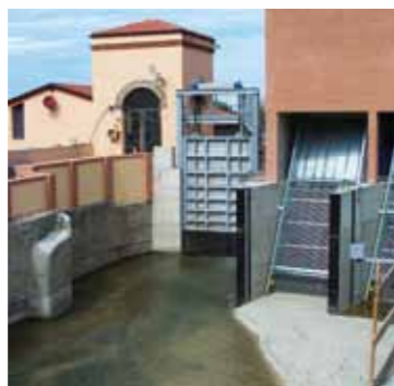
4. La Canonica - Centrale idroelettrica: il canale compie qui il primo salto d'acqua, utilizzato dal mulino dei Canonici Renani (sec. XII), da una cartiera e da un Canapificio (1851), in parte recuperato come sede della Casa della Pace La Filanda. La centrale (2013) è dotata di due turbine e produce energia pulita per il Comune di Casalecchio. Si raggiunge da via Panfilii-via Canonica; linee bus 89, 20, ferm. Croce. Per info: eventi@consorzireno-savena.it - tel. 051.6493527.
