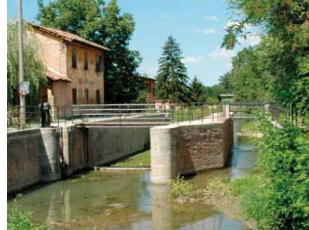
11. Sostegno Torreggiani: conca di forma esagonale di fine '500 con cassa di manovra posta tra il canale di navigazione detto Fossette e il Canalazzo scaricatore. Si raggiunge con sentiero ciclabile tra i due canali che inizia sotto il ponte dell'ex fornace Galotti, o da via Beverara-via del Sostegno; linee bus 17, 30, ferm. Tangenziale Lame.
