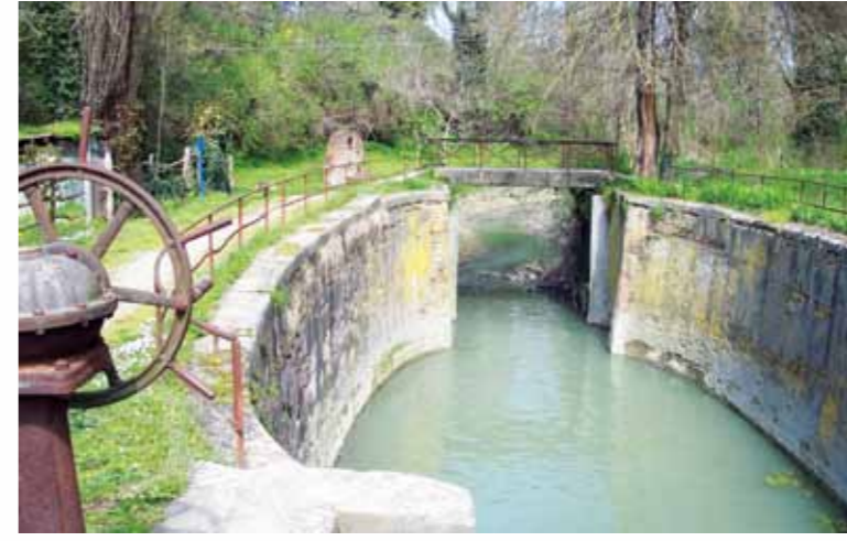
14. Sostegno di Corticella: eretto in forma ovale dal Vignola (1548), conserva le manovre della Riva Calzoni; nei pressi sono visibili il "pelago", alimentato da una derivazione del canale, e la fontana della Gabbella Grossa, un tempo utilizzata dai barcaioli. Si raggiunge da via dell'Arcoveglio-strada privata dopo il civ. 186. Linee bus 11, ferm. Rotonda Giardini; 27, ferm. Sole via delle Ponti. In bicicletta, oltre il Ponte Nuovo, sentiero segnalato a sinistra del canale.
