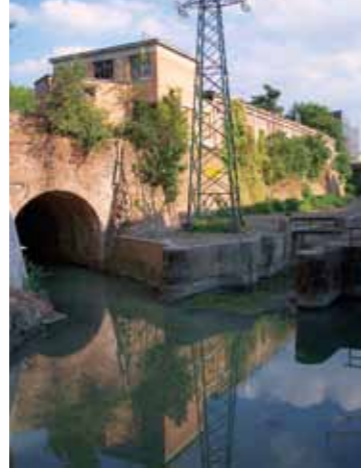
7. Sostegno della Bova: costruito nel luogo dell'antico porto del Maccaugno (sec. XIII), il più vicino alla città prima dell'intervento del Vignola (1548). Qui il canale Navile, alimentato dal canale Cavaticcio, riceve le acque riunite dell'Aposa e del canale delle Moline. Linea bus navetta 4, ferm. Bovi Campeggi.
